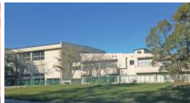
元幼稚園側からみた八幡公民館
