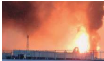
東日本大震災でコスモ石油プラントが爆発炎上
