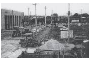
建設進む駅西口整備事業
