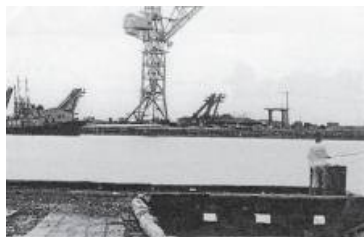
大型浚渫船が海中の土砂を掬い上げる
