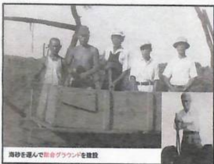
海砂を運んで新会グラウンドを建設
