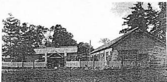
初代八幡中学校の建設
