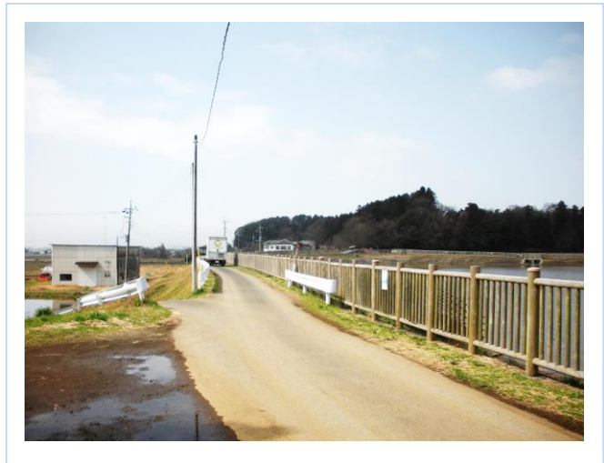
右：袖ヶ浦市高谷 高谷堰堤 奥に見える小山は、標高約40m で久留里道の通っている所で、 今歩いてきたところである。
