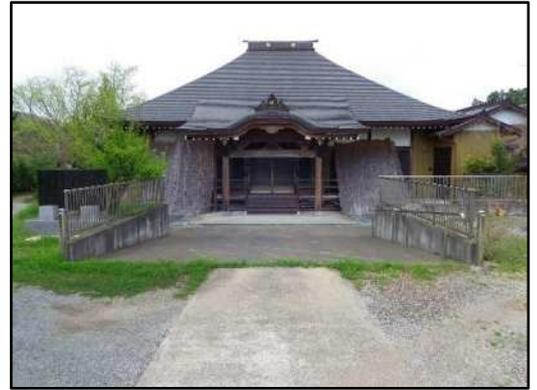
本堂は、明治6年の小学校令に従い、明治7年より小学校として寺子屋授業を始めたが、明治7年12月25日夜に火災により本堂と庫裡を全焼した。再建協議の結果、曹洞宗常盤寺本堂を解体し、明治12年に現在の地に建立された。昭和4年に茅葺き屋根からトタン葺き屋根に改修され、更に昭和46年に瓦トタン葺き屋根に改修されたが、トタンの錆がひどくなり、雨漏りの心配も出て、西光寺三百周年の記念事業として、銅板葺き屋根に改修となった。(改修の説明石碑の文を引用)
