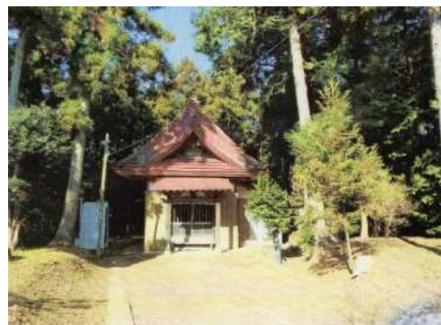
白山神社の本殿。内部に三社が納められている
