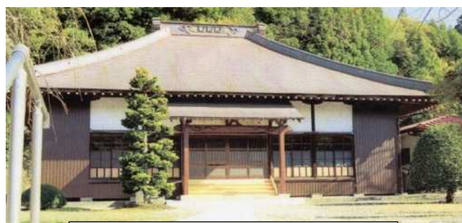
平成27年に大改修された本堂
