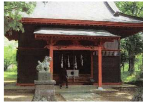
銅葺き入母屋造り拝殿
