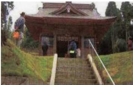
平成 19 年に建て替えられた銅版葺き入母屋造の拝殿。
