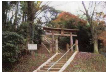
平成 19 年に竣工した神代杉の両部鳥居と 20 段の階段
