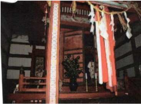
本殿内部の様子。脇障子に彫刻あり
