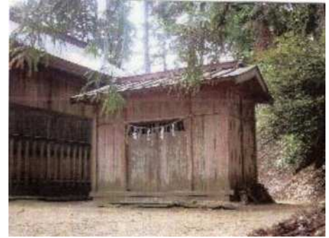
本殿は瓦葺入母屋造、拝殿は亜鉛版葺入母屋造
