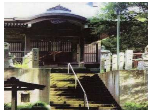
平成9年に大改修された本殿
