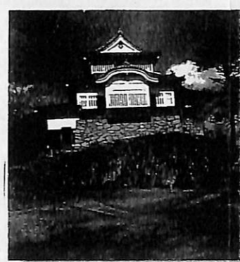
◆ 備前松山城天守 岡山県高梁市・JR備前線備前高梁駅下車 天守南面。山城の天守としては現存唯一のもので、臥牛山の小松山山頂に建つ。二重三層の小型の層型天守であるが、南正面に底破風の出窓(写真中央)、東・北面には入母屋造りの突出部を付け、さらに西面には平櫓から伸びる波櫓(写真左)が天守登り口として付属した複雑な構造となつている。諸史料や慶長期の意匠などからみて慶長期以前にさかのぼる天守を水谷氏が天和元年~3年(1681~83)に改築したものと考えられる。
