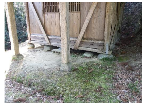
本殿基礎材の置き石が懐かしい
