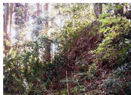
(い)の深さ5 mほどの大堀切
