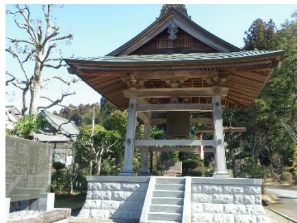
平成5年に再建された鐘楼
