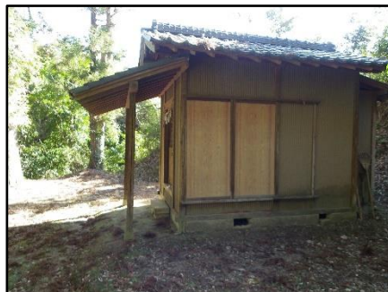
本殿右側を写す
