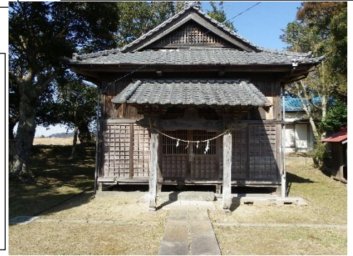
建屋の倒壊防止の支え柱
