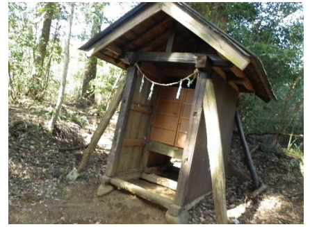
建屋の倒壊防止の支え柱
