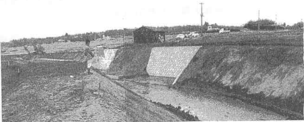
同上 (昭和59年2月撮影) 改修後
