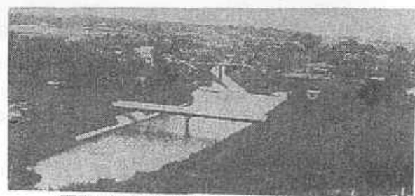
昭和50年村田川の一次改修 （河口より5600m完了） （市原市草刈地先）
