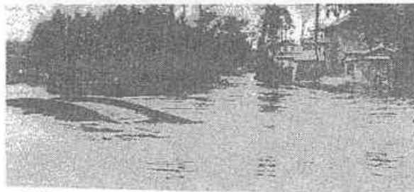
昭和35年頃の氾濫況、沈みゆく昭代橋 （市原市草刈地先）
