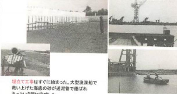
埋立て工事はすぐに始まった。大型浚渫船で救い上げた海底の砂が送泥管で運ばれあっという間に完成した
