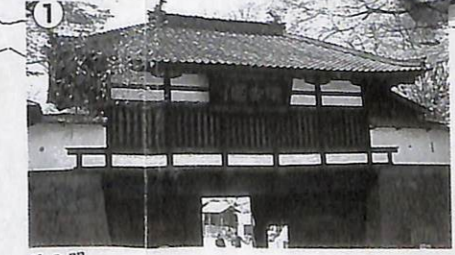
三の門 寄棟造りの二層の城門で、元和元年(1615年)に創建。寛保2年(1742年)の大洪水で流失し、明和二年(1765年)に再建。両側に矢狭間・鉄砲狭間が付けられた戦国式な建物で正面にある「懐古園」の大額は徳川家運の筆。国指定重要文化財。
