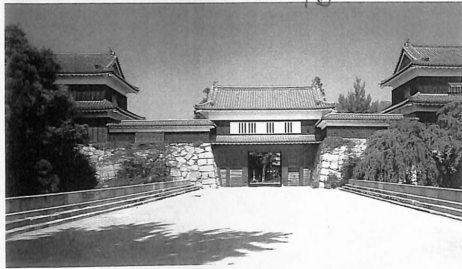
東虎口櫓門と 北櫓(右)・南櫓(左) 北櫓と南櫓は、廃城によって民間に 払い下げられると、妓楼として再利 用されるという数奇な運命をたどっ た。上田城には、合計7基の櫓が あったものの、当時の名称は不明で、 方位による名称は、戦後に再移転さ れたのちにつけられた。 写真/世界文化フォト
