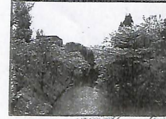
堀と土塁(土居) 上田城の堀は、ほとんどが素掘りのままであり、また掘上げた土で土塁を築いている。
