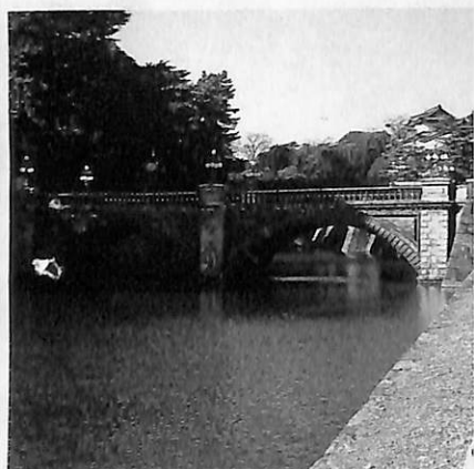
三橋と二重橋 手前の石橋は西の丸大 台22年（1389）に架け替えたもので、そ 二重橋。左端の門はかつての西の丸大手門で、 吾正門（現存）。「二重橋」の名は、堀が深 く、舟を三重に組んだことからついた。
