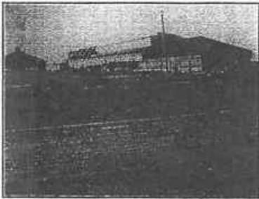
竣工式を迎えた富士電機 工場 (S.36)
