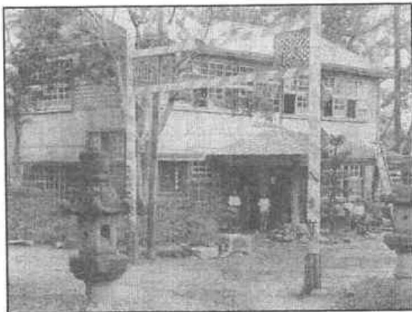
③⑥八幡公民館竣工(昭和 23 年 7 月)
