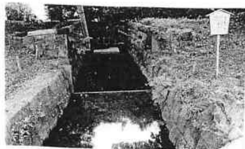
海水取り入れ口
