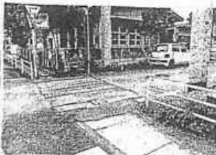
浜本側参道石橋跡
