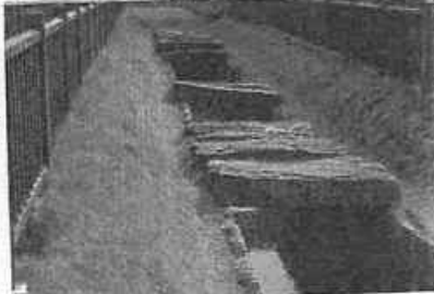
石樋の移築復元
