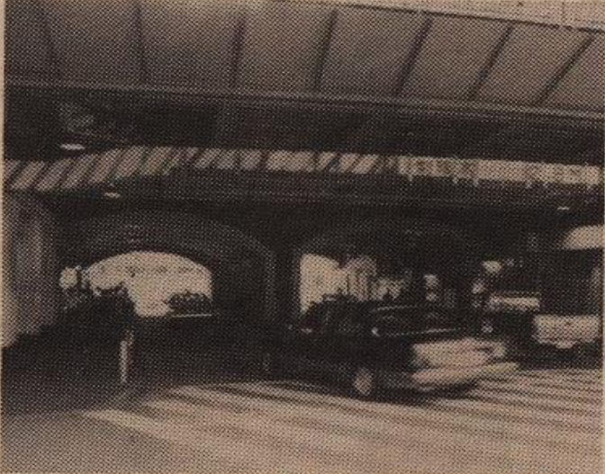
現在の有楽町駅中央ガード(関東大震災を契機にアーチ二区画をぐりぬいた横断道路ができてグンと便利になった)
