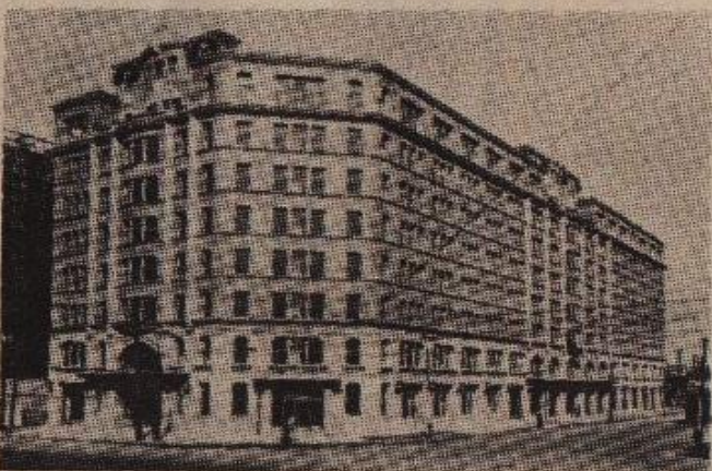
昭和4年竣工直後の三信ビル＝クラシックな装飾が今では貴重な存在になっている(三井不動産提供)
