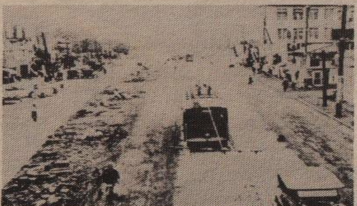
昭和2年に行なわれた晴海通りの拡幅工事—右側は現在の電氣ビルとパークビル、左側は劇場街になっている(『有楽町今と昔』から)
