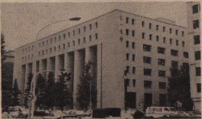
建物の自重で地下に沈める潜函工法がとられた第一生命ビル。戦後はGHQ（連合軍総司令部）となった
