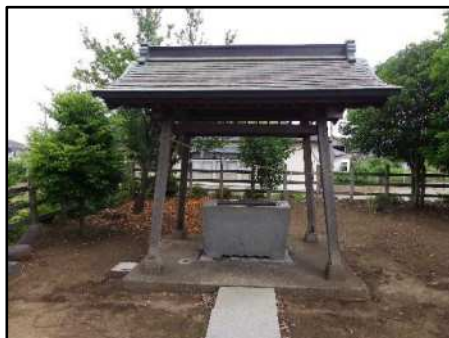
昭和57年に奉納の手水舎
