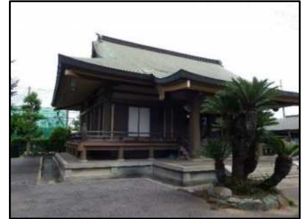
善養院の本堂の建物
