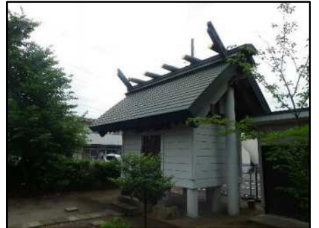
本殿建物を右側から写す
