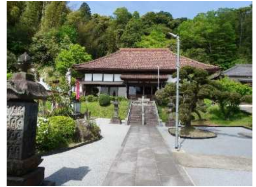
真高寺本堂建物と参道
