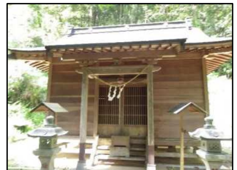
白山神社の本殿の建物
