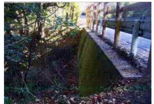
キャンプ場の南側にある深さ4m、深さ7mほどの堀切1の跡
