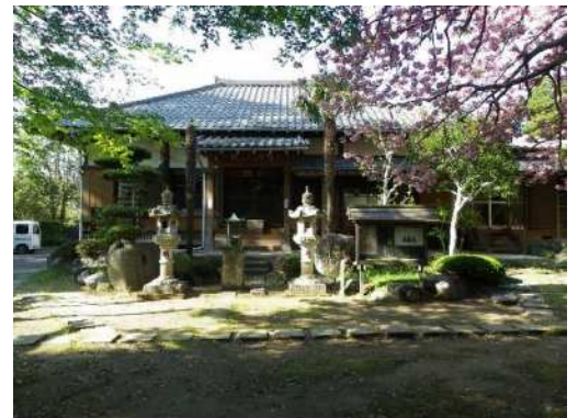
平成15年に改修された本堂建物
