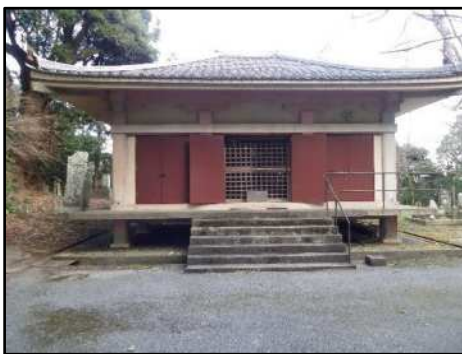
橘禅寺薬師堂の建物
