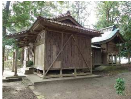
拝殿と幣殿奥の本殿の建屋
