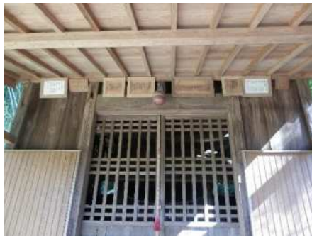
苗鹿神社本殿正面の入口
