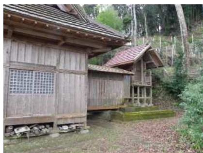
奥から本殿・幣殿・拝殿
