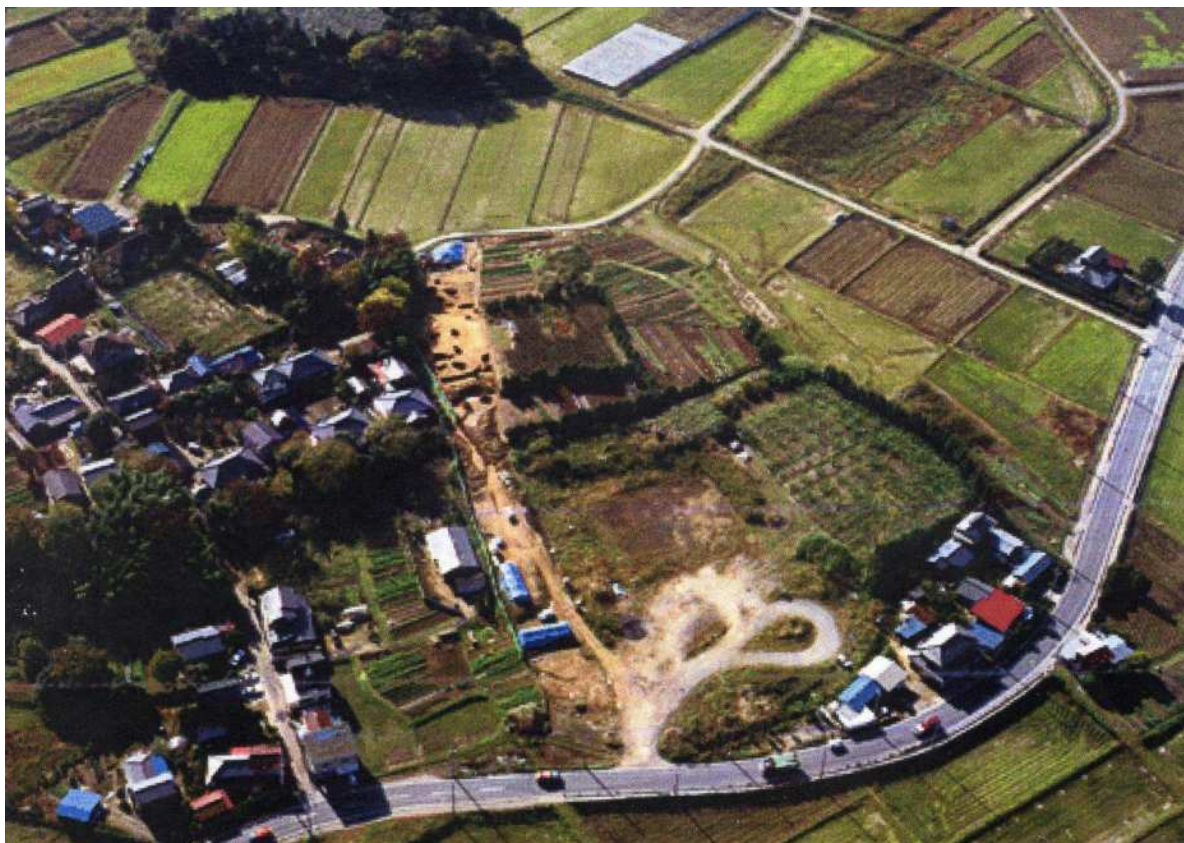
戦国期に大改修された台地先端部。中央の帯は発掘調査地で、地下式杭が点のように見える
