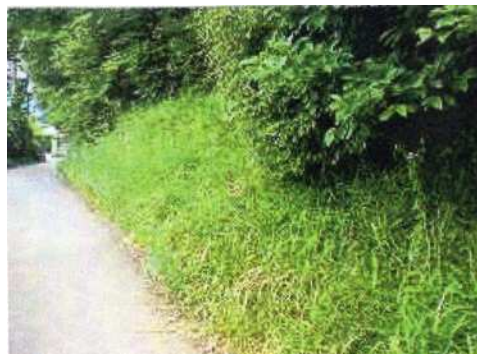
西側の土塁を外側から見たところ
