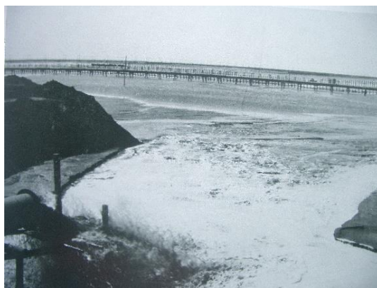
(サンドポンプによる埋立工事)
